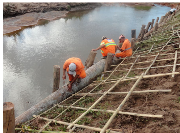
Figura 9: Amarração das toras para melhor fixação. Arroio Viúva Tereza. Coord. UTM: 397786/ 6530260 – 22S. Março 2014
