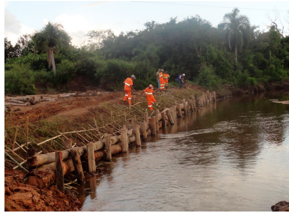
Figura 11: Projeto de bioengenharia de solos em conclusão. Arroio Viúva Tereza. Coord. UTM: 397786/ 6530260 – 22S. Março 2014
