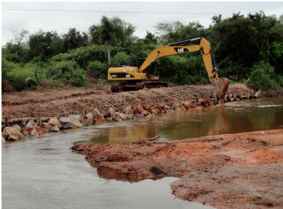
Figura 12: Pedras alocadas na margem após a conclusão do projeto de bioengenharia de solos. Arroio Viúva Tereza. Coord. UTM: 397786/ 6530260 – 22S. Março 2014
