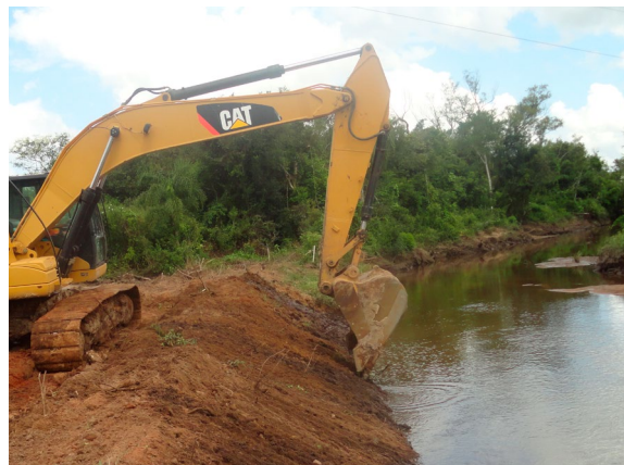
Figura 3: Conformação das margens do arroio Viúva Tereza, em ângulo de 45°. Coord. UTM: 399596/6567653 – 22S. Março 2014
