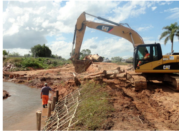
Figura 7: Ramos de Phyllanthus sellowianus fixados com as tramas de bambu. Arroio Viúva Tereza. Coord. UTM: 397786/ 6530260 – 22S. Março 2014
