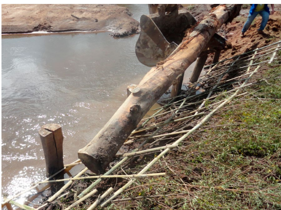
Figura 8: Tora de eucalipto sendo disposta longitudinalmente à margem do arroio Viúva Tereza. Coord. UTM: 397786/ 6530260 – 22S. Março 2014
