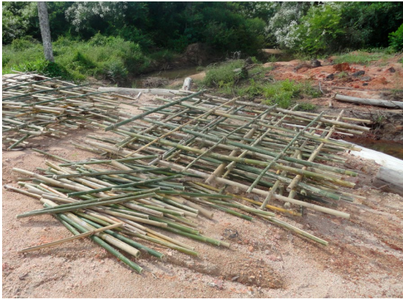
Figura 6: Confeção das tramas de bambu para fixação dos feixes vivos. Arroio Viúva Tereza. Coord. UTM: 399596/6567653 – 22S. Março 2014
