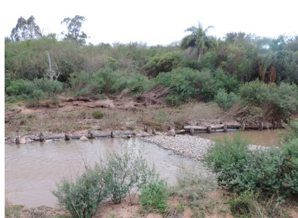
Figura 21: Área adjacente a Parede Krainer com instalação de vegetação inicial e bioengenharia de solos estável. Arroio Viúva Tereza. Coord. UTM: 397786/6530260 – 22S. Janeiro 2017
