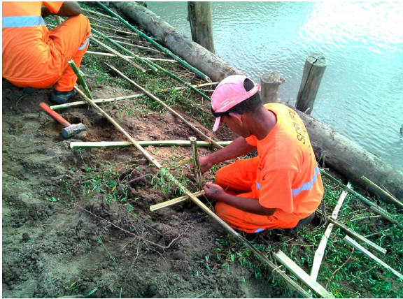
Figura 10: Fixação das tramas de bambu. Arroio Viúva Tereza. Coord. UTM: 397786/ 6530260 – 22S. Março 2014
