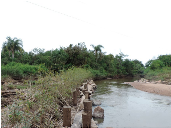
Figura 18: Área adjacente a Parede Krainer com instalação de vegetação inicial e bioengenharia de solos estável. Arroio Viúva Tereza. Coord. UTM: 397786/6530260 – 22S. Fevereiro 2016
