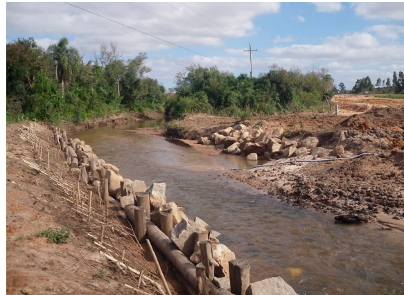
Figura 13: Pedras alocadas na margem. Arroio Viúva Tereza. Coord. UTM: 397786/6530260 – 22S. Abril 2014
