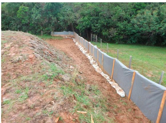
**Figura 5:** Barreira de contenção confeccionada com geotêxtil em operação durante fase de extração da jazida E-4. Novembro 2014
