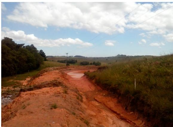
**Figura 9:** Bacia de contenção/sedimentação de finos de solo instalada na porção sul da argileira E-4. Dezembro 2013
