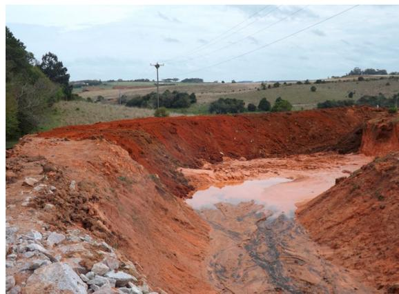
**Figura 10:** Bacia de contenção/sedimentação da porção sul da E-4 ampliada devido ao aumento da área de contribuição de drenagem ocasionado pelo avanço da lavra. Setembro 2014
