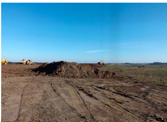
**Figura 7:** Remoção da camada orgânica em uma frente de lavra da jazida E-4. Junho 2013
