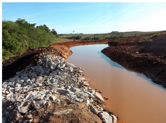
**Figura 6:** Enrocamento no ponto de escoamento da bacia de sedimentação da porção sul da E-4. Setembro 2014
