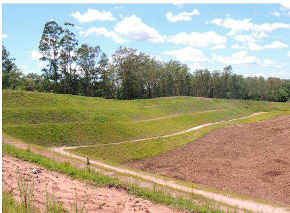
**Figura 11:** Jazida com a configuração final prevista no PRAD sem previsão do preenchimento das cavas. Jazida EC-03, município de Camaquã. Dezembro 2014
