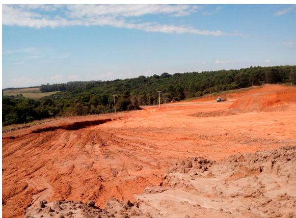
**Figura 13:** Conformação topográfica sendo realizada na jazida E-4. Março 2014
